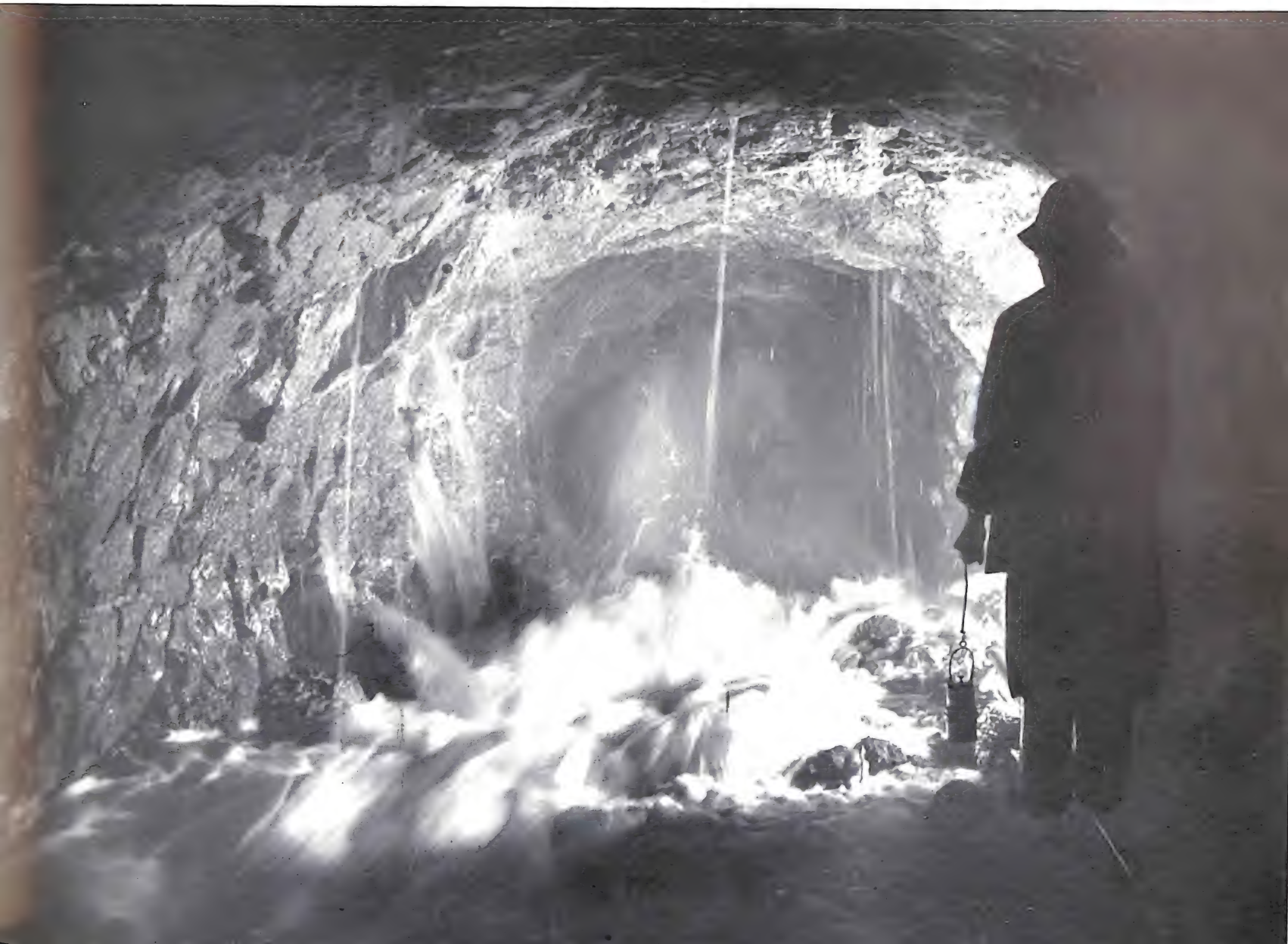
Monteponi - La fronte di una galleria durante il tracciamento di un livello profondo.
